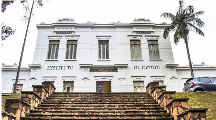
Figura 1. Fachada do Edifício Vital Brazil. (Foto de: Alf Ribeiro, 2010).
