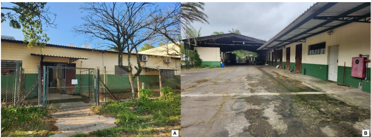
Figura 3 (A) Entrada principal; (B) Entrada alternativa (fundos).
